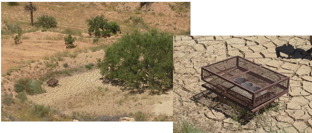
Figure 1-8 : Photos d'un évacuateur tubulaire inséré dans un jesser
